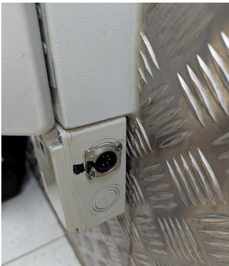
Das Bedienteil der Zeitanlage wird am seitlichen Kasten unterhalb des Anschlusskastens angeschlossen.
